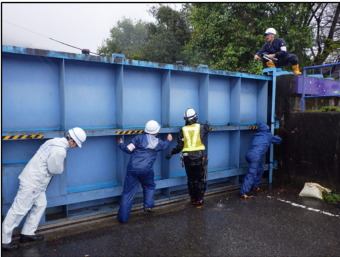
大前町陸閘の操作訓練及び点検
