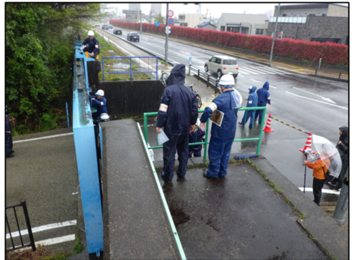
大前町陸閘の点検
