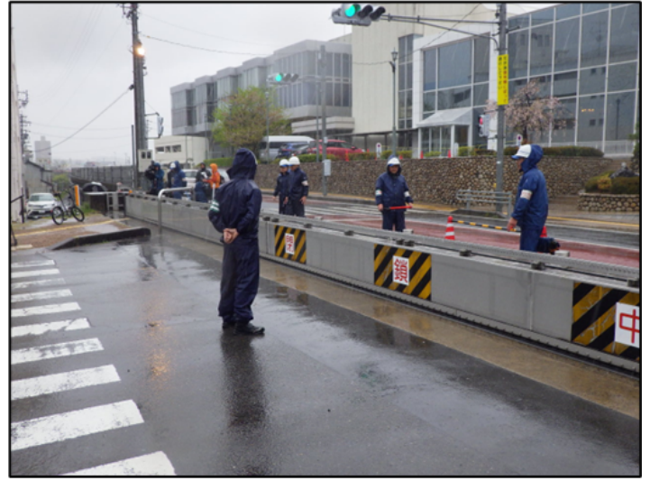
築地陸閘閉鎖及び点検状況
