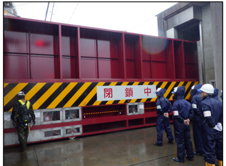
長良南町陸閘の閉鎖及び点検状況
